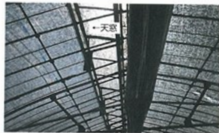
写真4 遮光資材（ダイオシード）の下で天窓を開けている所
